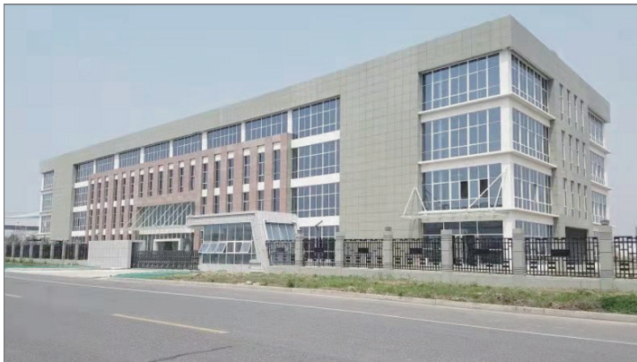
興美利大健康產業園區馬鞍山廠房
