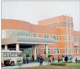
興田合肥廠成立於安徽合肥高新技術產業開發區內。
